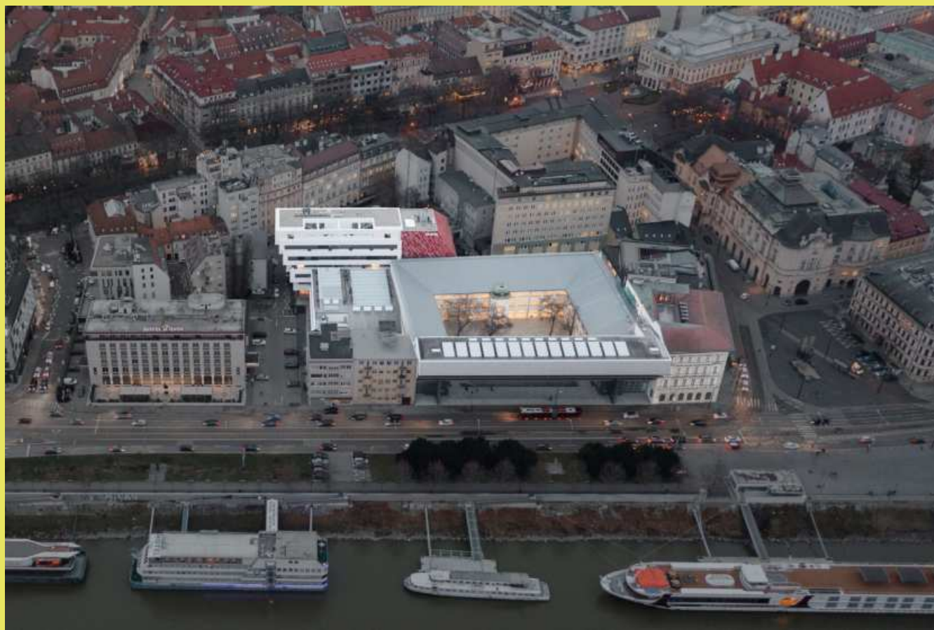
Az új raktár elhelyezkedése. Location of the new depository. Kép | Image: architekti BKPS
