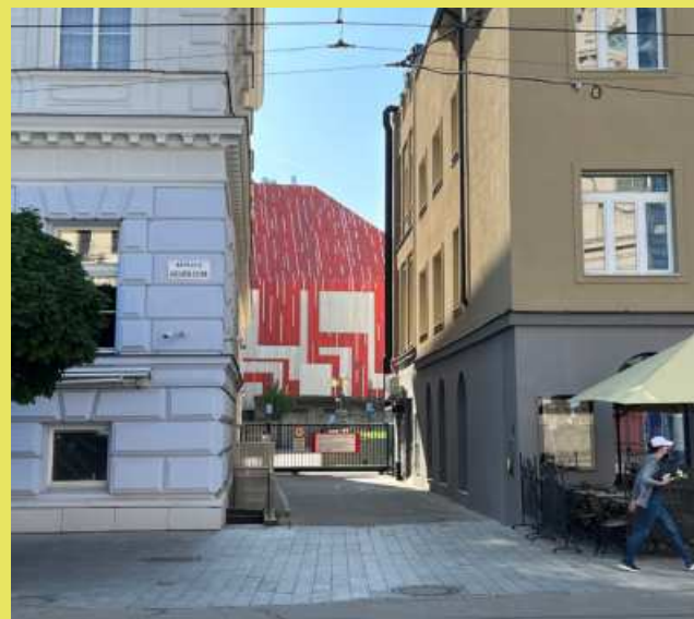
Az új raktár nézete az udvarból. The depository as seen from the courtyard. Kép | Image: architektn BKPS
