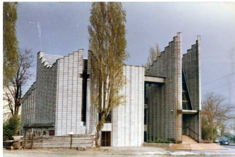
A Mindenszentek-templom építés közben. Forrás: Szabó István archívuma, MÉM MDK The All Saints Church during construction. Image: Szabó István's archives, HMA MPDC
